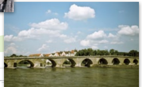
Die Steinernen Brücke in Regensburg war jahrhundertlang der einzige feste Donauübergang zwischen Ulm und Wien.
